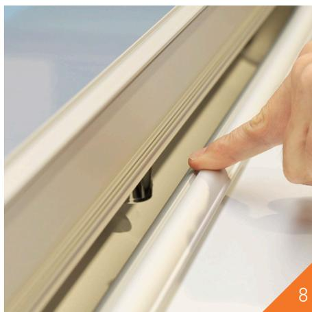
8 Die Klemmleiste schließen und erneut gleichmäßigen Druck auf die gesamte Leiste ausüben.
